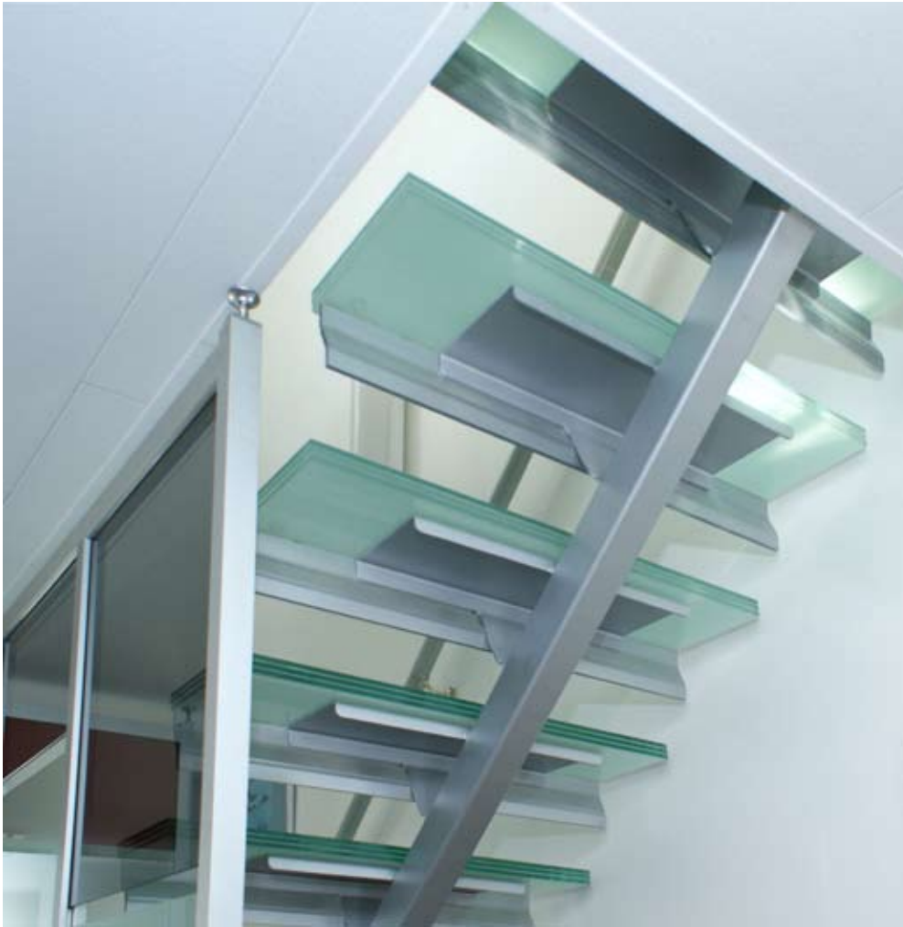
Karkaistusta kolmikerroksisesta lasista tehdyt portaat. Reiska on valmistanut omin käsin alla olevan teräsrakenteen.
